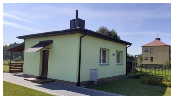
Świetlica wiejska w Lipnikach po remoncie
