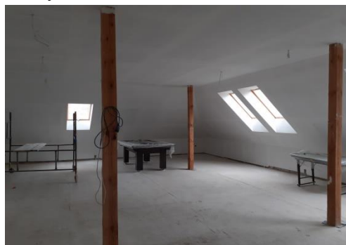
Docieplone poddasze w świetlicy wiejskiej w Uścieńcu
