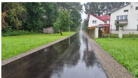
Droga gminna Nr 130626W w Starym Pilczynie
