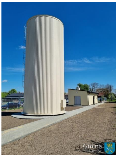
Zmodernizowana SUW w Dąbrowie
