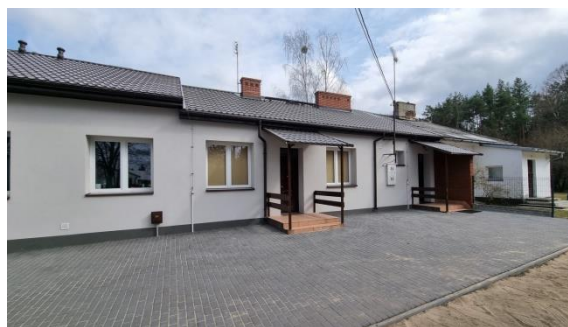
Budynek w Starym Helenowie po termomodernizacji
