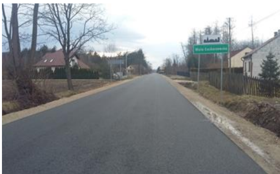
Droga powiatowa Nr 1345W w Woli Łaskarzewskiej po przebudowie
