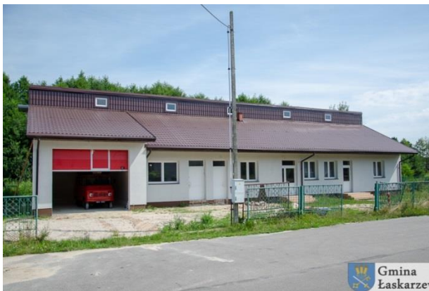
Świetlica wiejska w Woli Rowskiej po rozbudowie
