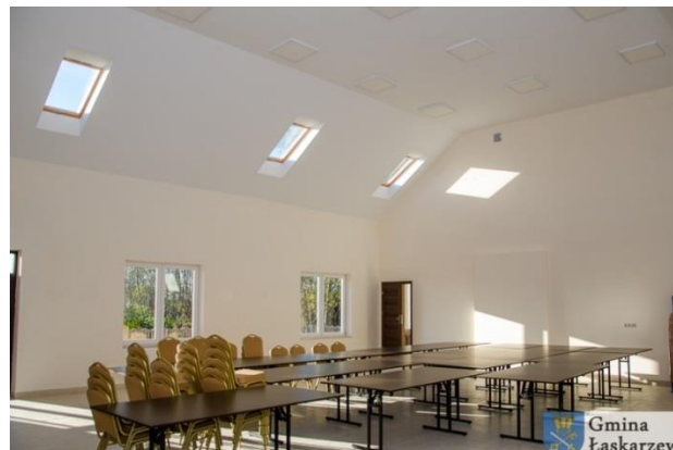
Świetlica wiejska w Uścieniu po przebudowie
