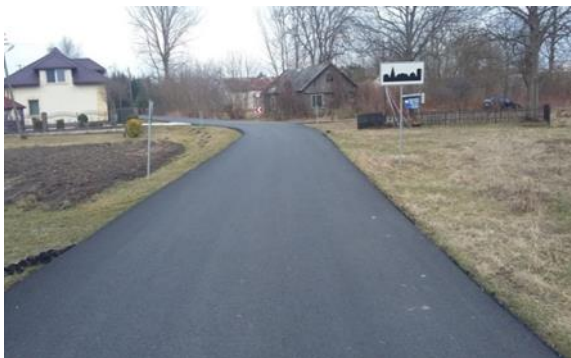
Droga gminna w m. Dąbrowa – Kolonia po modernizacji
