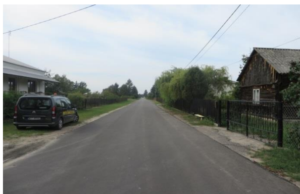
Przebudowa drogi gminnej w Starym Helenowie
