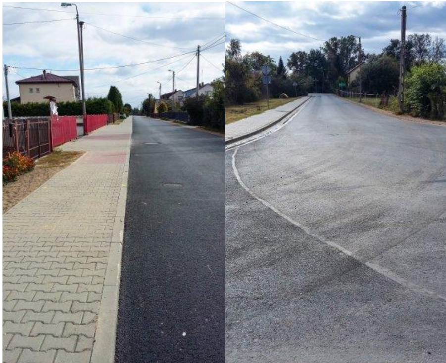
Droga powiatowa Nr 1345W w m. Melanów i Stary Pilczyn po przebudowie
