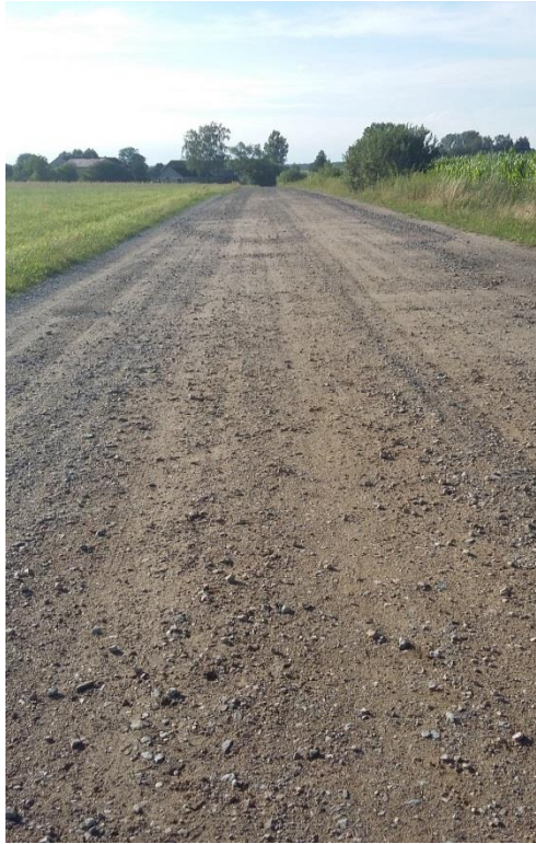
Wyremontowana droga gminna o nawierzchni tłuczniowej w m. Zygmunt
