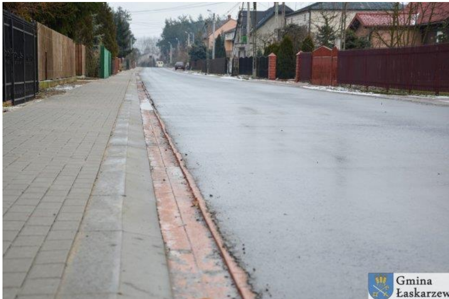
Droga gminna Nr 130606W w m. Sośninka po przebudowie
