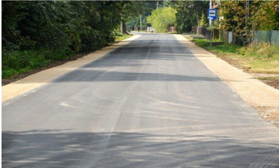
Droga powiatowa Nr 1323W w m. Krzywda po przebudowie
