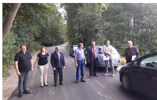
Odbiór drogi gminnej Nr 130609W Izdebno Kolonia – Wola Rowska wykonanej przez PRD Lubartów S.A.
