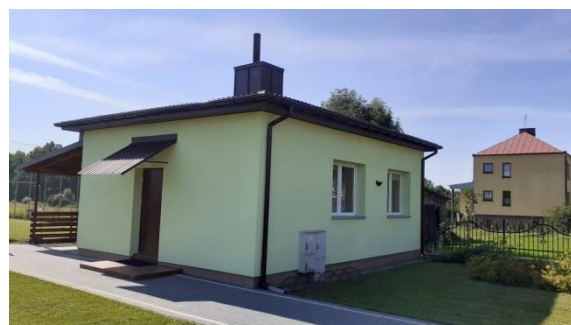
Świećlica wiejska w Lipnikach po remoncie
