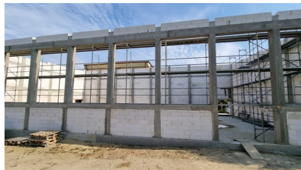
Roboty przy budowie hali sportowej przy ZS w Izdebnie
