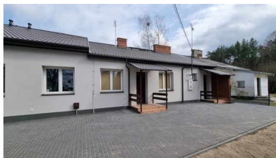
Budynek w Starym Helenowie po termomodernizacji
