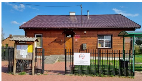
Świećlica wiejska w Budach Krępskich po remoncie
