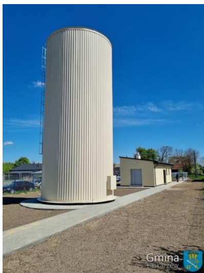
Zmodernizowana SUW w Dąbrowie
