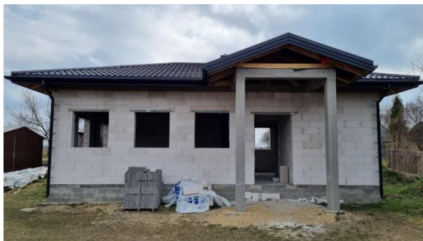
Stan surowy świetlicy wiejskiej w Nowym Pilczynie
