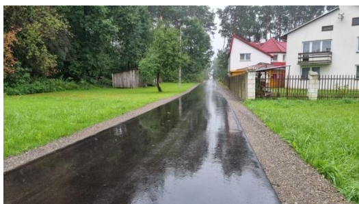
Droga gminna Nr 130626W w Starym Pilczynie
