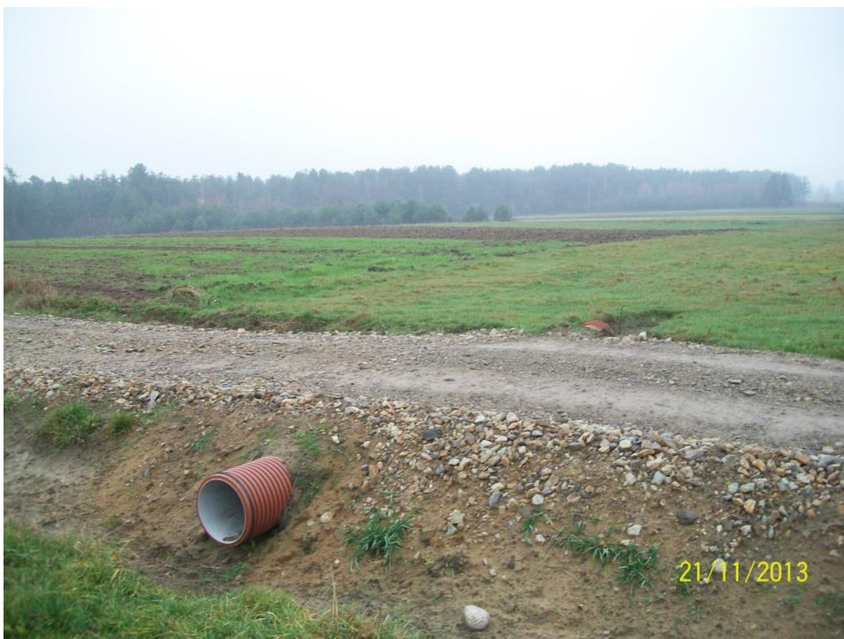
Zdjęcie nr 3. Budowa przepustów pod drogami gminnymi 10 .
