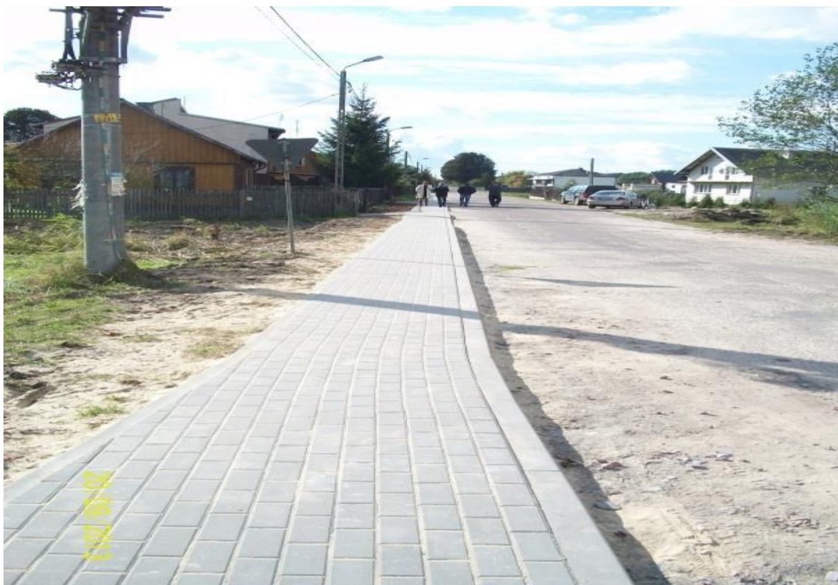
Zdjęcie nr 2. Budowa chodnika w jednej z miejscowości gm. Łaskarzew.
